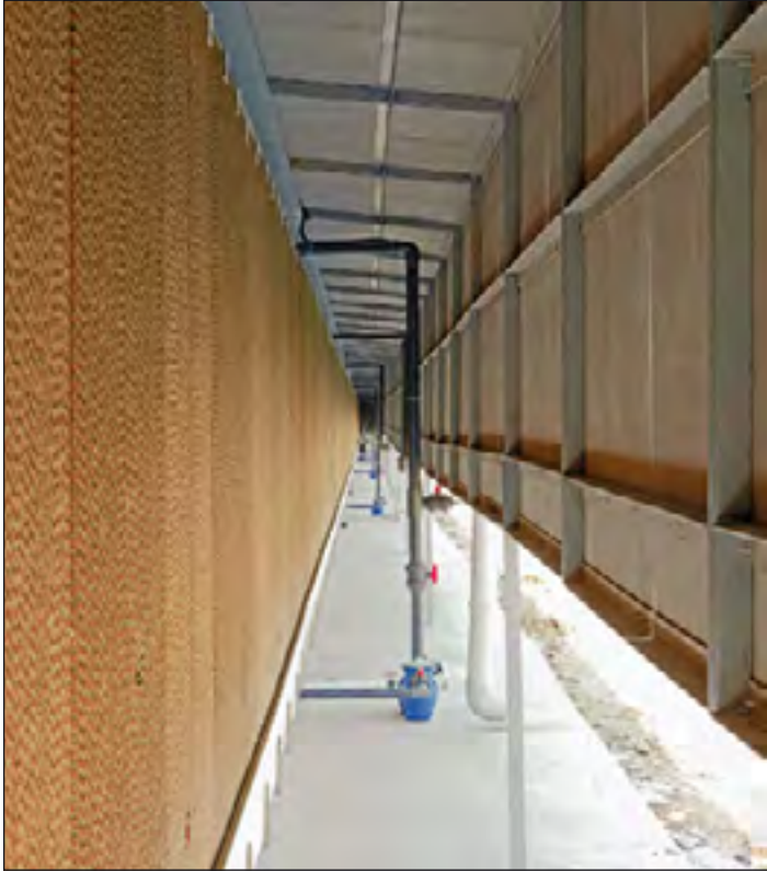
防风和防尘保护，避免阳光直射到水帘上
